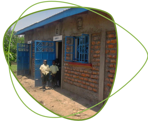
Die ersten Ziegel-Klassenräume
