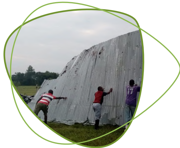
Kaputtes Dach der Schule
